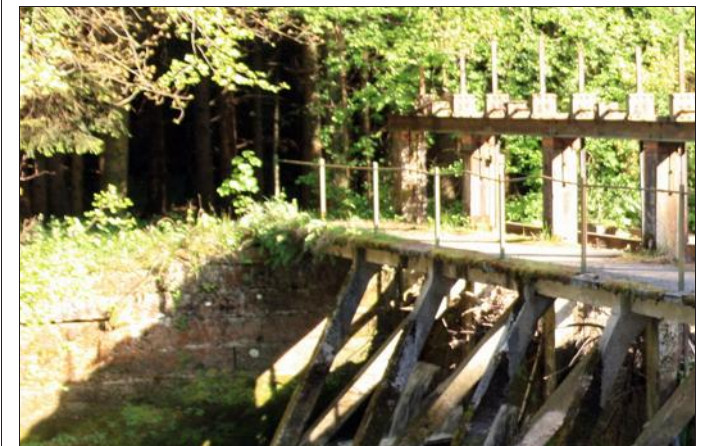
Les membres d'Ercisol relocalisent la production d'énergie, comme ici, sur le cours de la Meurthe, à Raon-l'Étape.
