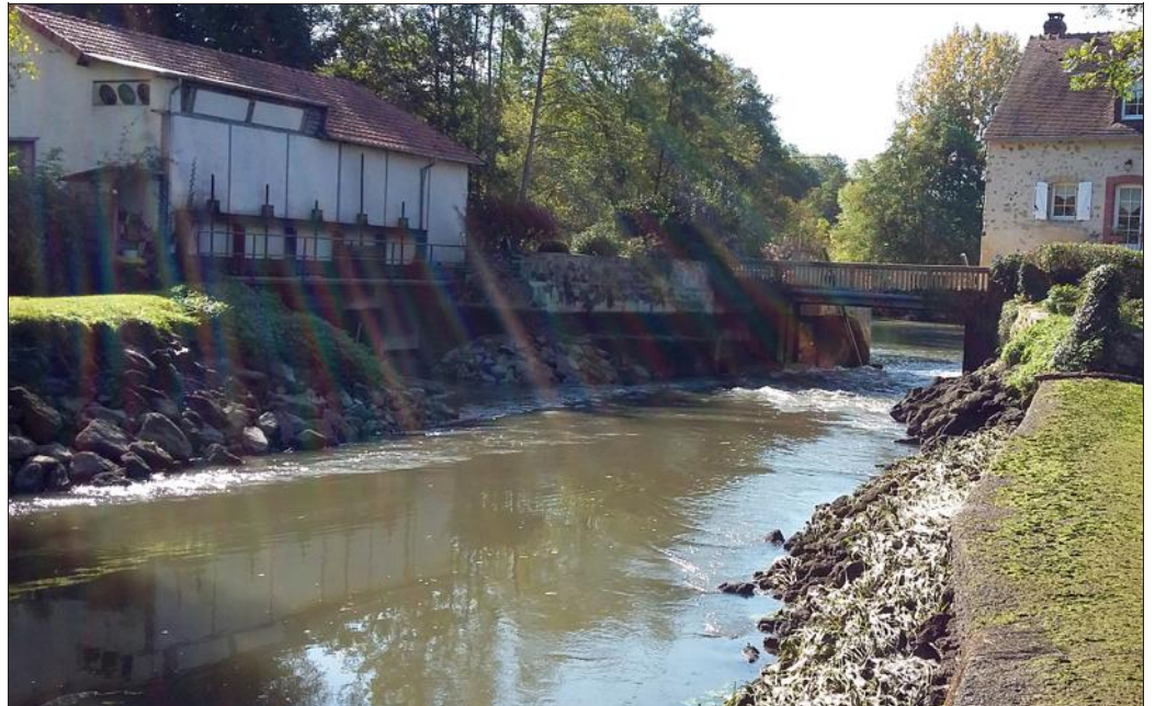
Les deux centrales sarthoises totaliseront une puissance de près de 400 kW.
